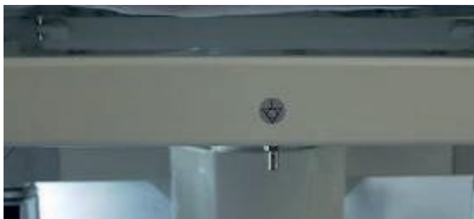
Fig. Conector de equalização potencial – macho
