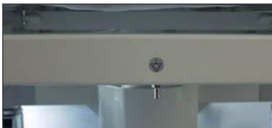
Afb. Equipotentiaalconnector – mannelijk
