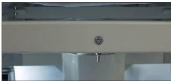
Fig. Prise mâle pour la compensation de potentiel
